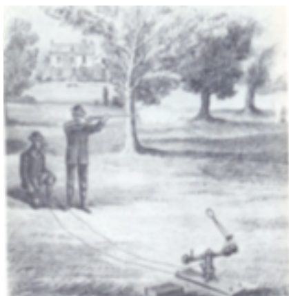
7. Tirando de la cuerda, la maquina lanzaba un "pichón" de arcilla.
