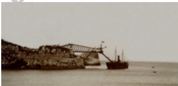
2. Vista del cargadero exterior de Urdiales
