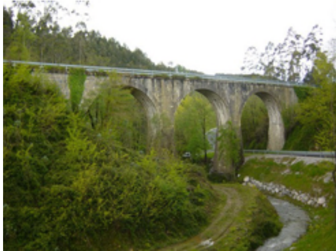
4 -Viaducto de los Vados.
