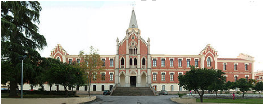
Nº 3. Hospital de los Marqueses de Linares
