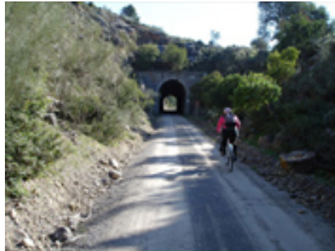
Ilustración 8. VV Almanzora. Puente
