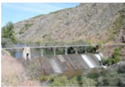
Nº4. Presa de la Parra
