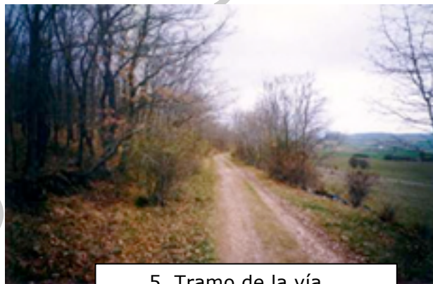
5. Tramo de la vía
