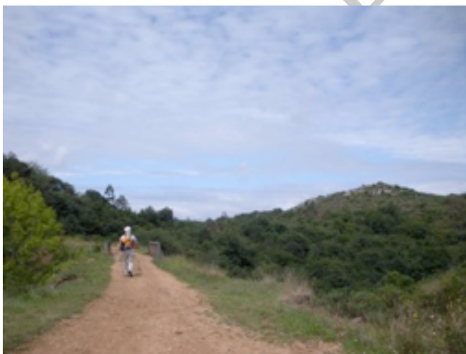
Foto 3 - Acercándonos al acueducto
