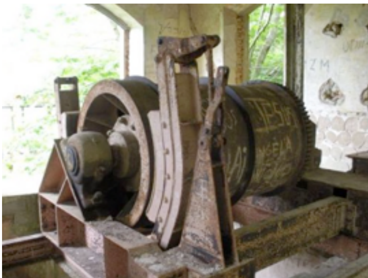
Foto 10 - Polea del Pozo Peñamontero
