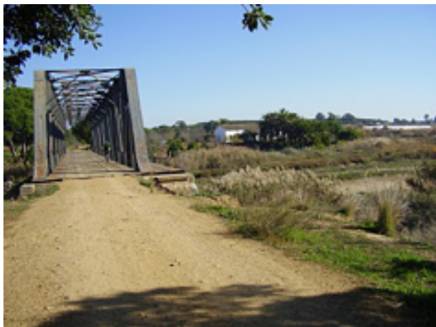
Fig. 7 Puente de la vía.
