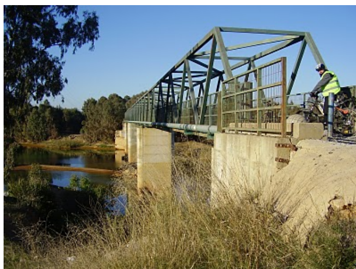
Fig. 4 Puente típico de la ruta.
