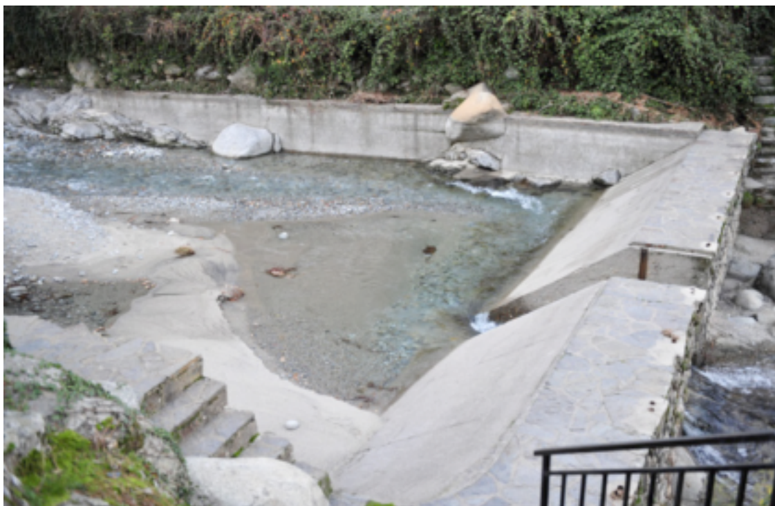
Ilustración 4: Vista panorámica de la piscina natural
