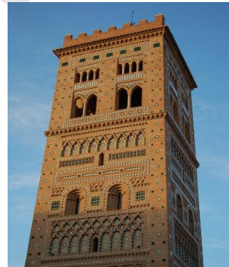
Foto 3. Torre de San Martín
