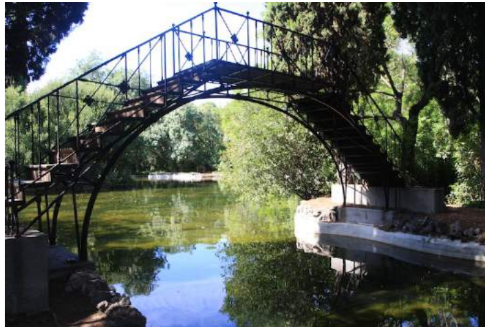
16. Puente de Hierro
