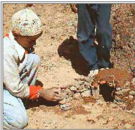
Construcción de un garaje según la forma tradicional, pueblo Aït Ighemour (montaña de Siroua), 1992, fotografía de J-P. Rossie.
